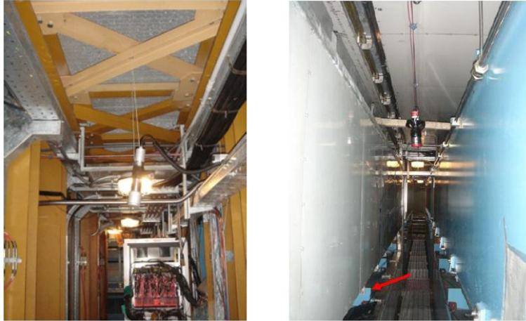
Abbildung 24: (links) Die erste Core Facility Messung. (rechts) Die zweite Messung. Bei der dritten Messung wurde der NaI-Detektor zwischen den Tanks der Core Facility gestellt (roter Pfeil).
